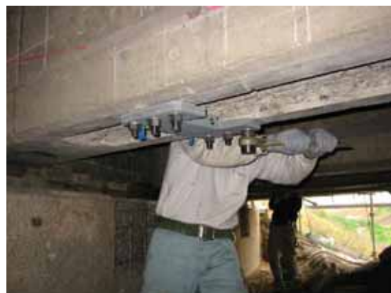
写真-解 4.7 固定プレートの設置
