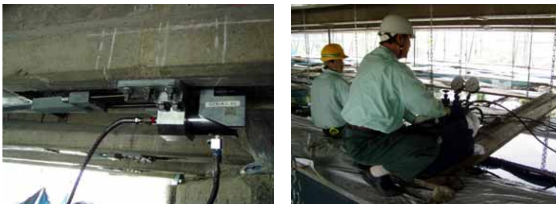
写真-解 4.17 アウトプレートの緊張
