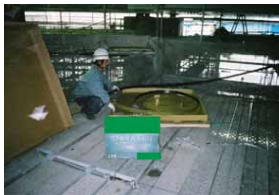
写真-解 4.12 プレートの引き出し
