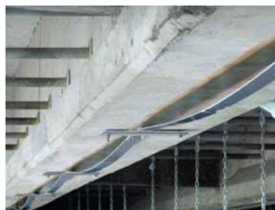
写真-解 4.14 中間定着体の仮固定
