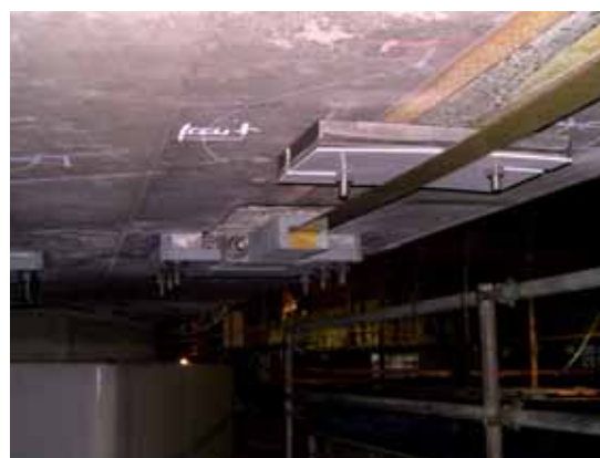
写真-解 4.11 偏向定着構造
