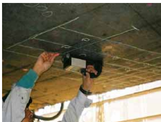
写真-解 4.2 RCレーダーによる探査
