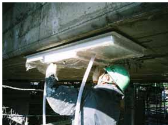
写真-解 4.19 保護カバーの設置
