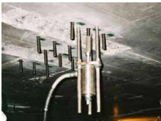
写真-解 4.5 アンカーの引き抜き試験
