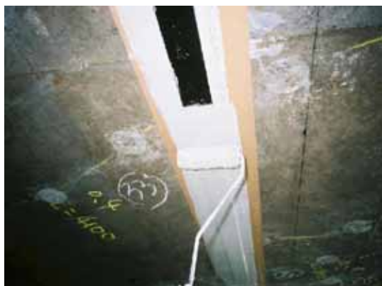
写真-解 4.21 炭素繊維プレートの仕上げ
