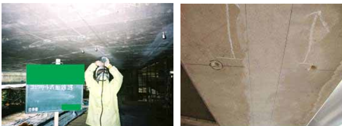
写真-解 4.8 コンクリートの表面処理
