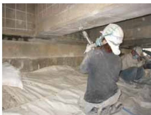
写真-解 4.4 定着部コンクリートのはつり
