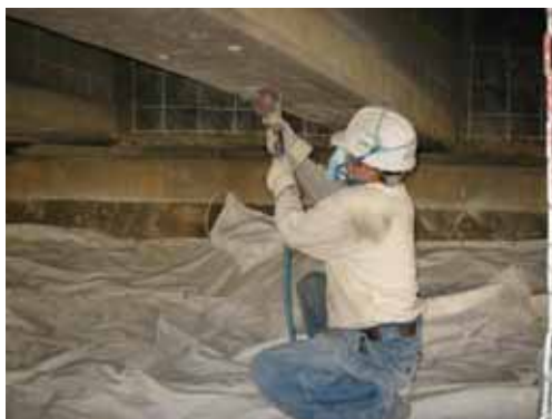
写真-解 4.4 定着部コンクリートのはつり
