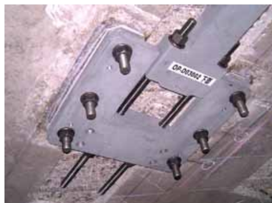
写真-解 4.16 緊張前の状況
