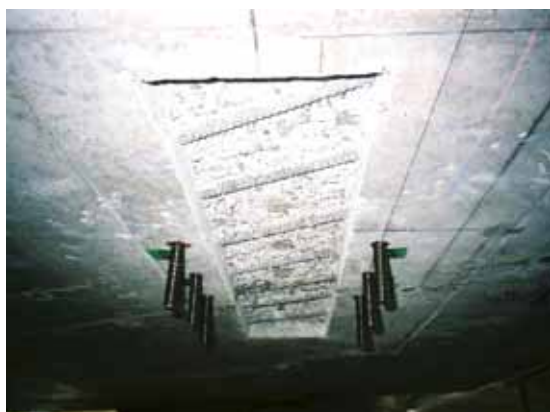
写真-解 4.6 固定プレートの設置前
