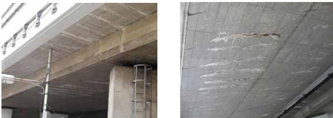
写真-解 4.1 既設のコンクリート構造物
