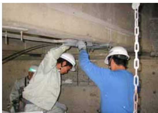
写真-解 4.13 定着体の設置
