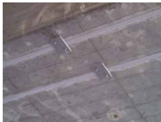
写真-解 4.21 炭素繊維プレートの仕上げ
