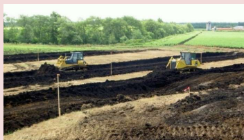
トンボを使った整地（ブルドーザ）
