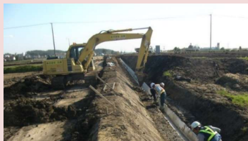
丁張りをを使った法面整形（バックホウ）
